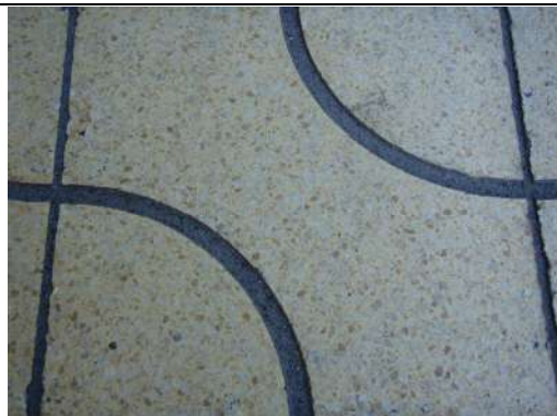
施工前の下地状況②
