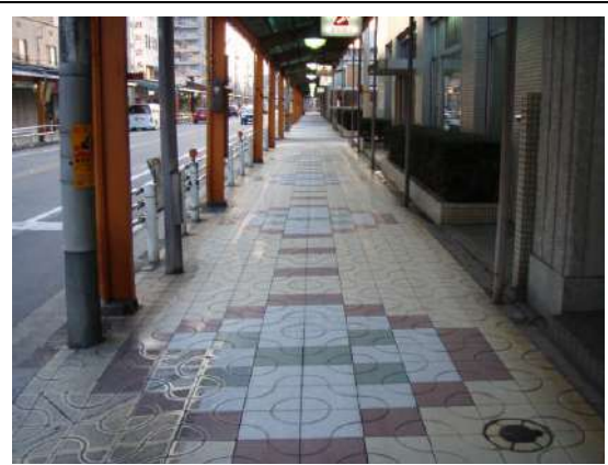
施工後の下地状況②
