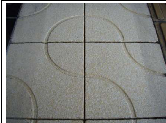
施工後の下地状況①
