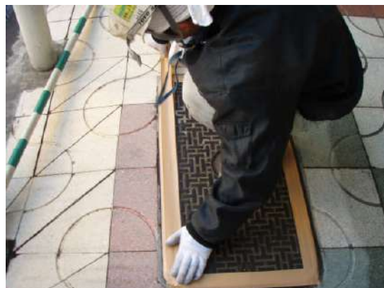
マンホール養生
