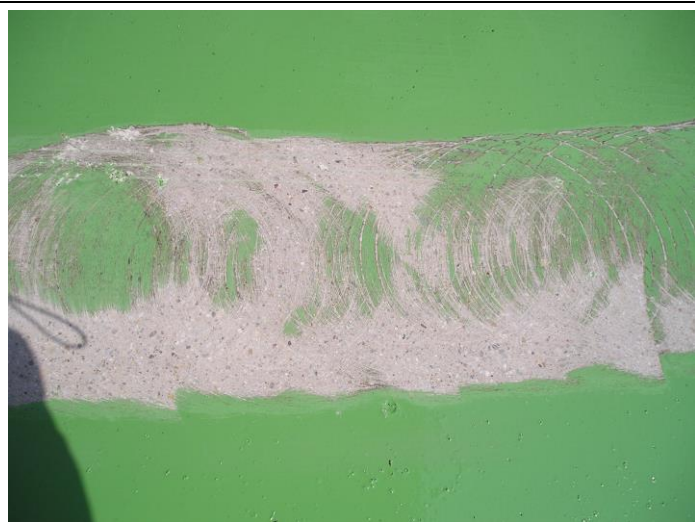
専用ダイヤによる研削過程（塗膜ローラー0.5mm程度）
