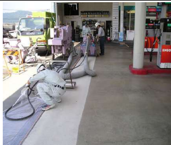
作業の様子① 予め、ガムテープ・マスキングテープ等で養生を行います。
