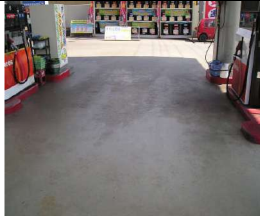
施工前の状況②
