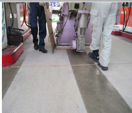
作業の様子③ メディア（鉄球）が飛散しないようにガードします。
