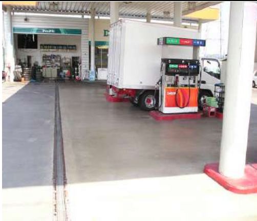
施工前の状況①
