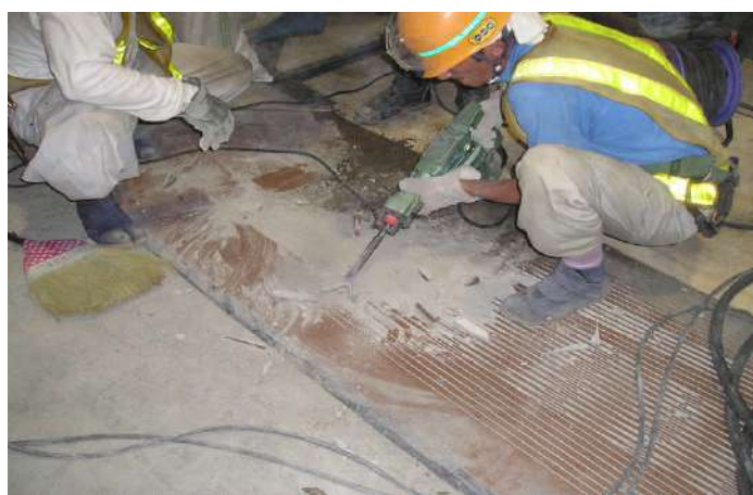
4・電動ピックによるはつり作業
