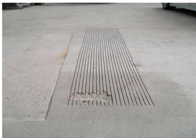
5・コンクリート 10 mm cutter 入れ状況
