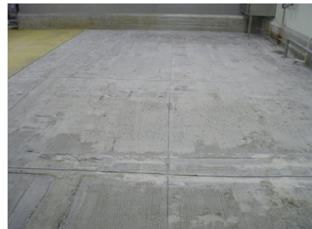
塗床撤去後の下地の様子②
