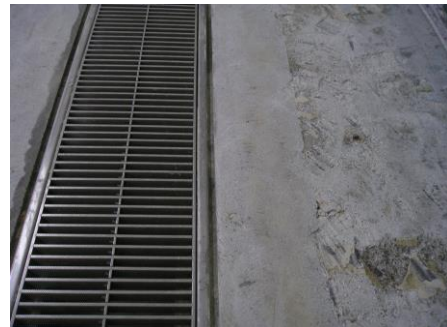
グレーチング周りカッター入れ
