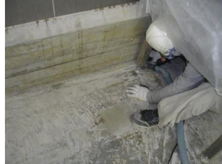
壁際・機械下・役物周りの状況② 機械下は、サンダーにて研磨します
