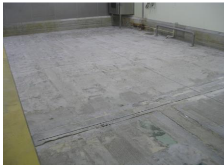
塗床撤去後の下地の様子①
