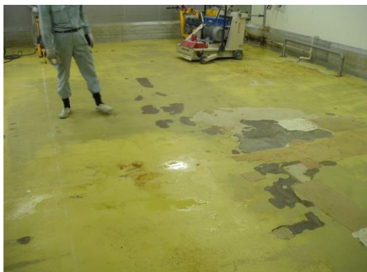
施工前の状況
