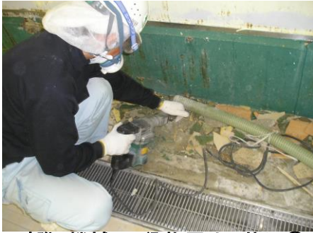
壁際・機械下・役物周りの状況① 切削機が使えない場合は、電動ハンマーにてはつり撤去となります
