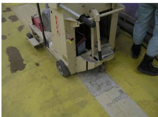
MMA樹脂モルタル切削撤去中 中型切削機にて樹脂モルタル撤去 集塵機付で粉塵をカット (10ミリ以下の樹脂モルタルの場合)
